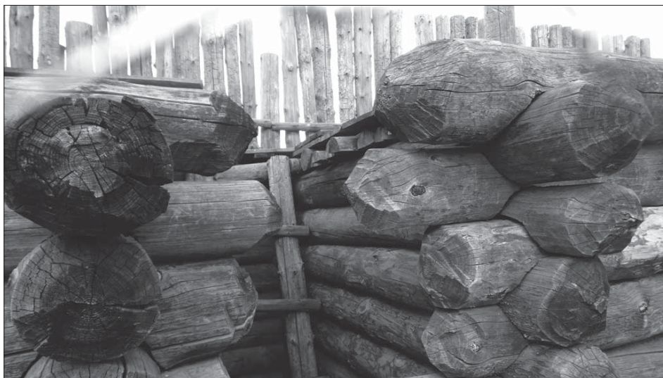
Ил. 42. Принцип на архитектурния гредоред на градището в Аркаим (възстановка; фотография)
